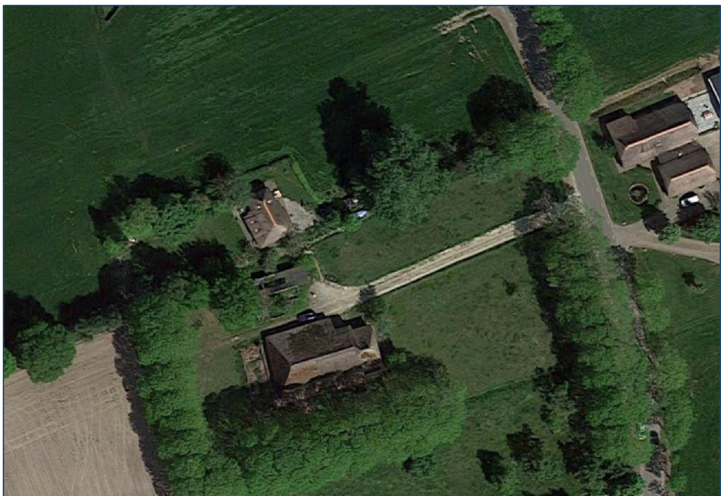
Fig. 1.1: Een weergave van het bestaande woning op het perceel Barsbeek 28 in Sint Jansklooster.
