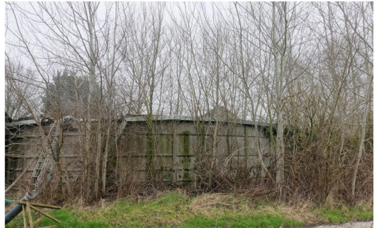
Te slopen mestlo
