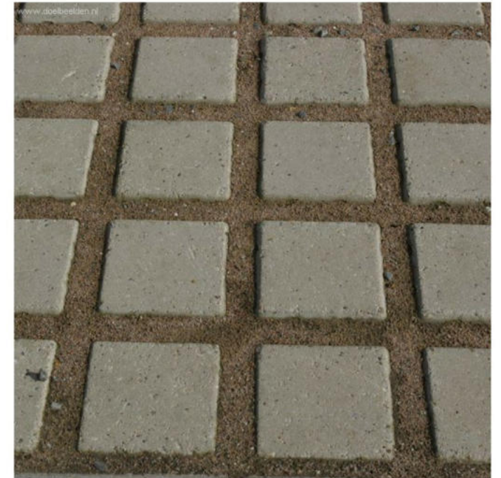
Grasbetonstenen (opstelplaatsen voor containers)
