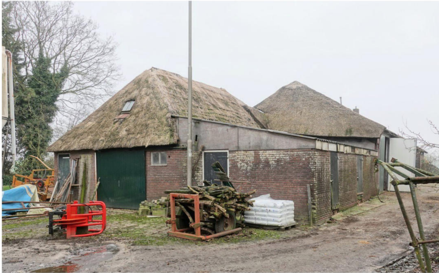
Te slopen aanbouw bij de boerderij
