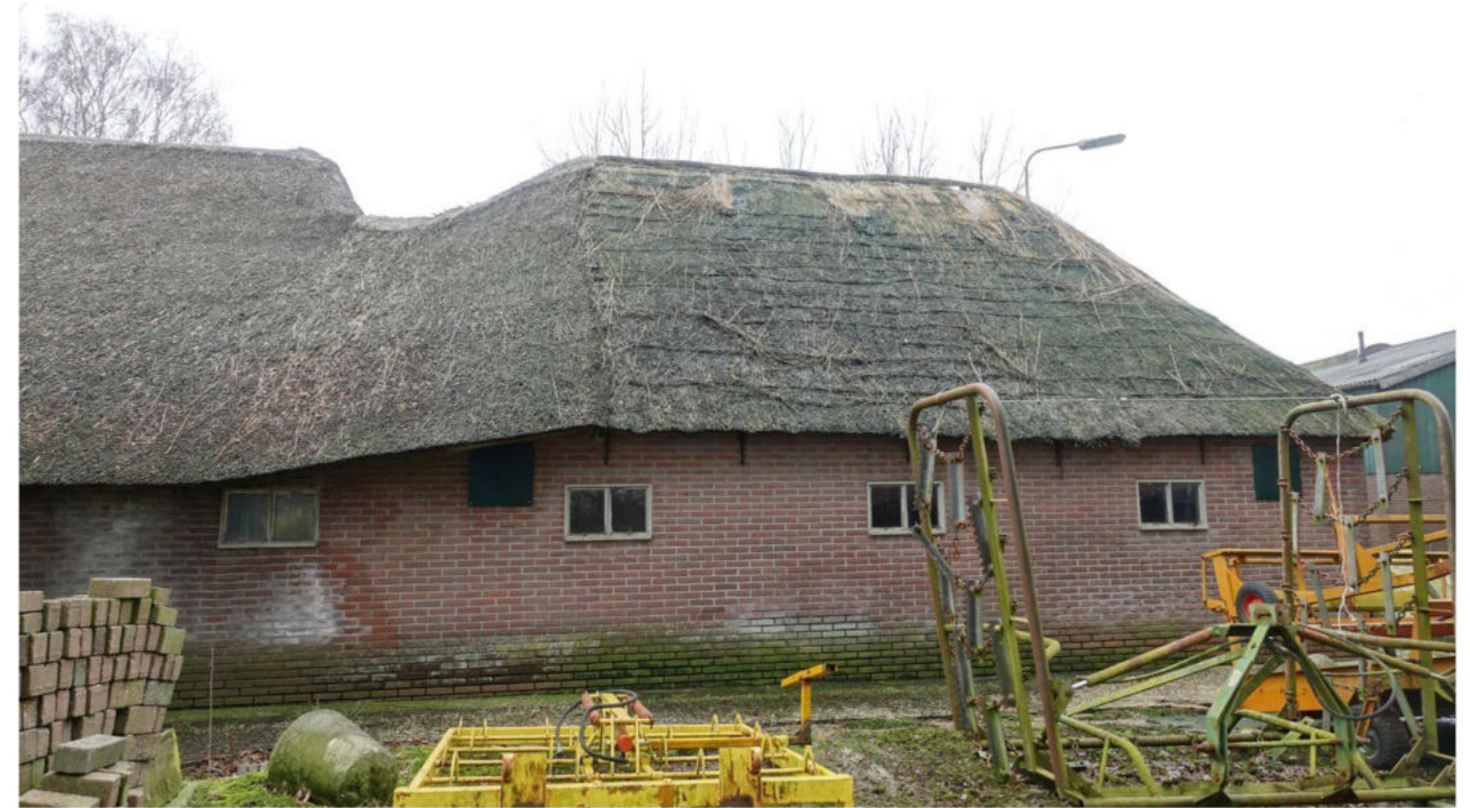
Achtergedeelte van de boerderij (zijgevel)
