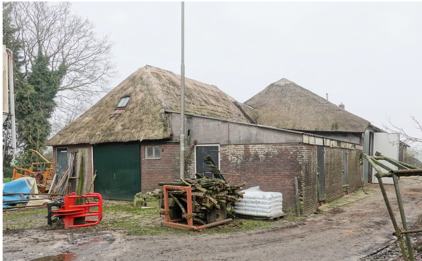
Te slopen aanbouw bij de boerderij
