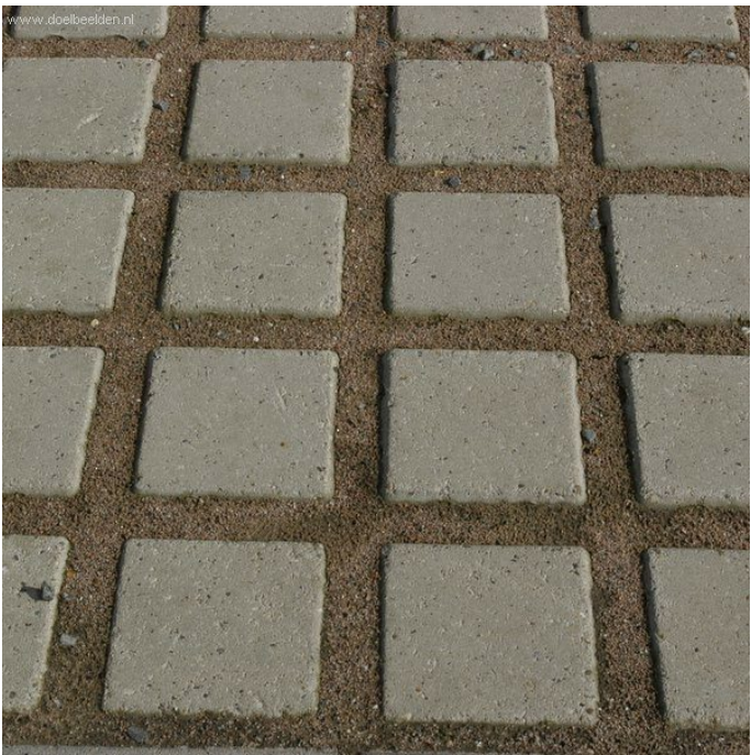
Grasbetonstenen (opstelplaatsen voor containers)
