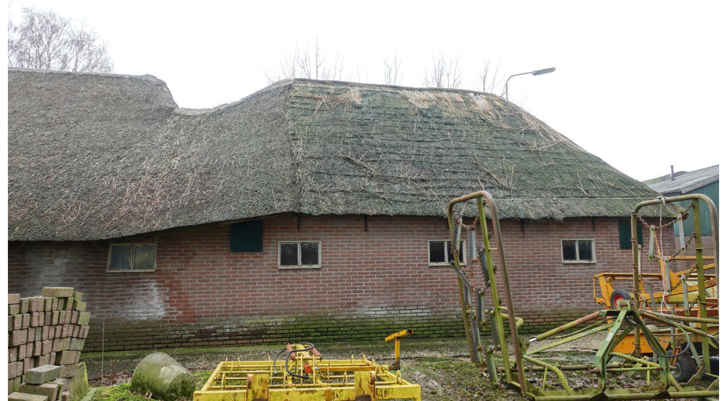
Achtergedeelte van de boerderij (zijgevel)
