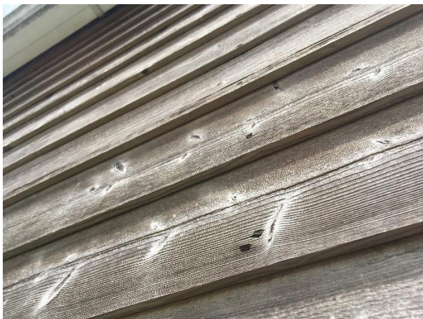
De planken sluiten strak op elkaar aan.
