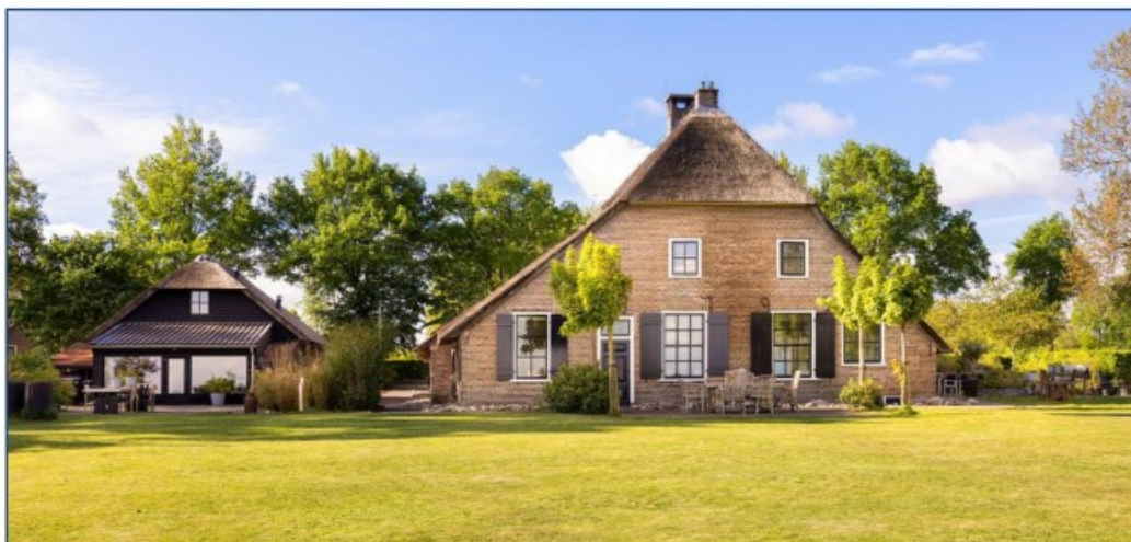
Fig. 2.5: Het bebouwingsbeeld van Leeuwte 51 (achtergevels van de bestaande bebouwing).
