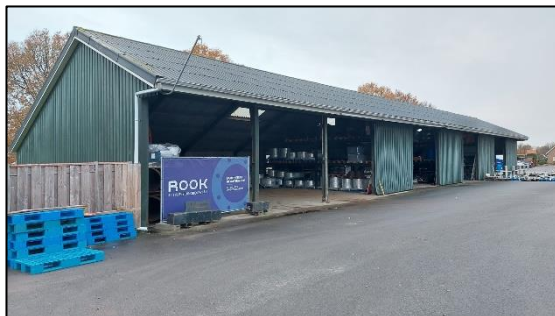
Afbeelding 2.6. Oostzijde open kapschuur.
