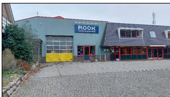
Afbeelding 2.2. Westzijde van de centrale loods met kantoorruimte.
