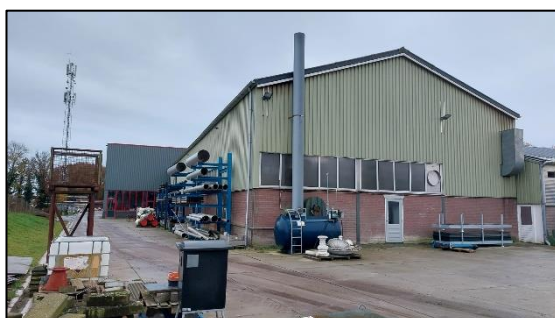
Afbeelding 2.4. Zuidzijde van de centrale loods.
