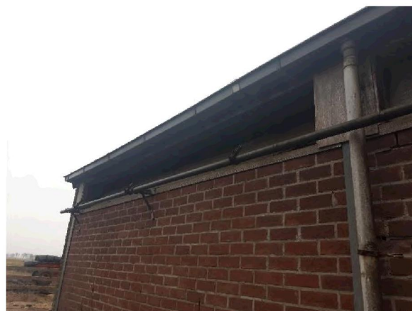
Figuur 2.3: Zijgevel stal noordwestzijde
