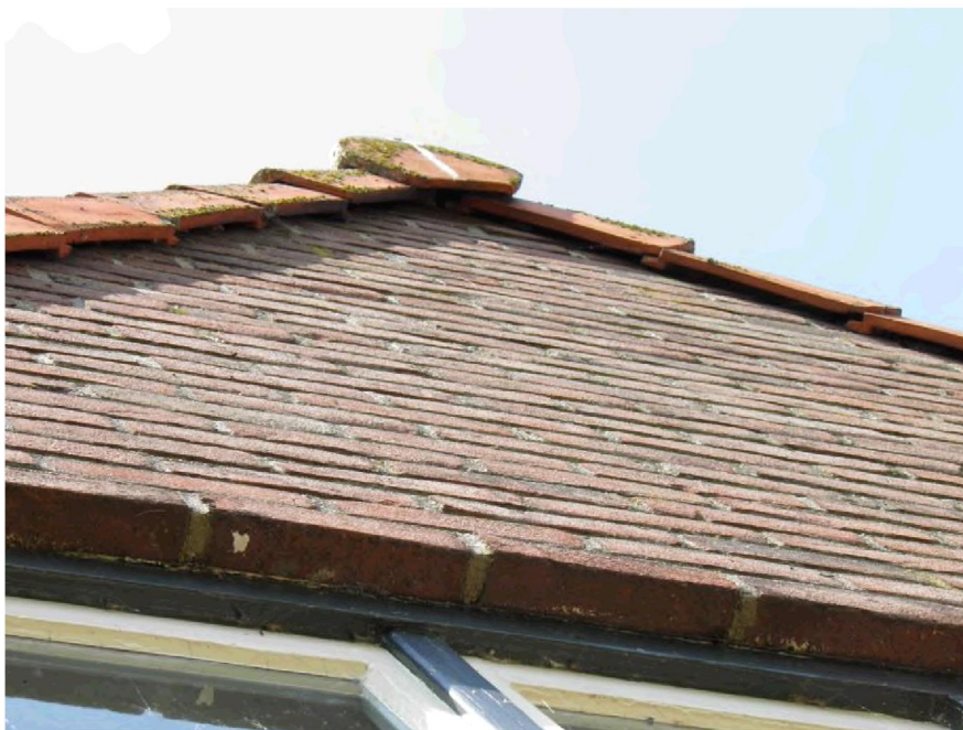
Figuur 8. De vleermuizen verlieten het pand onder de dakpanrand bij de nok van het dak.
