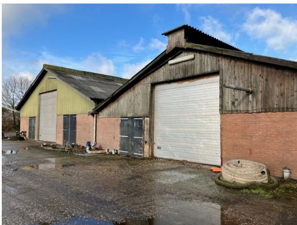
• Afbeelding 8: Achterzijde te slopen stallen
