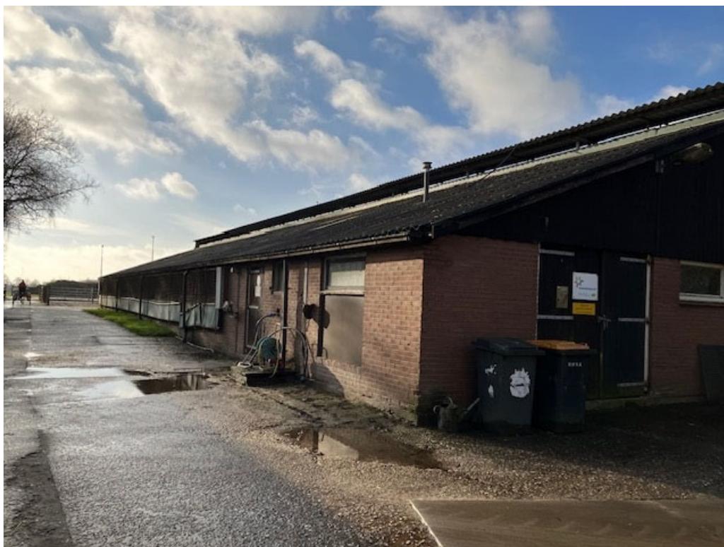
• Afbeelding 5: Linker zijgevel te slopen stallen rechtsachter de bedrijfswoning
