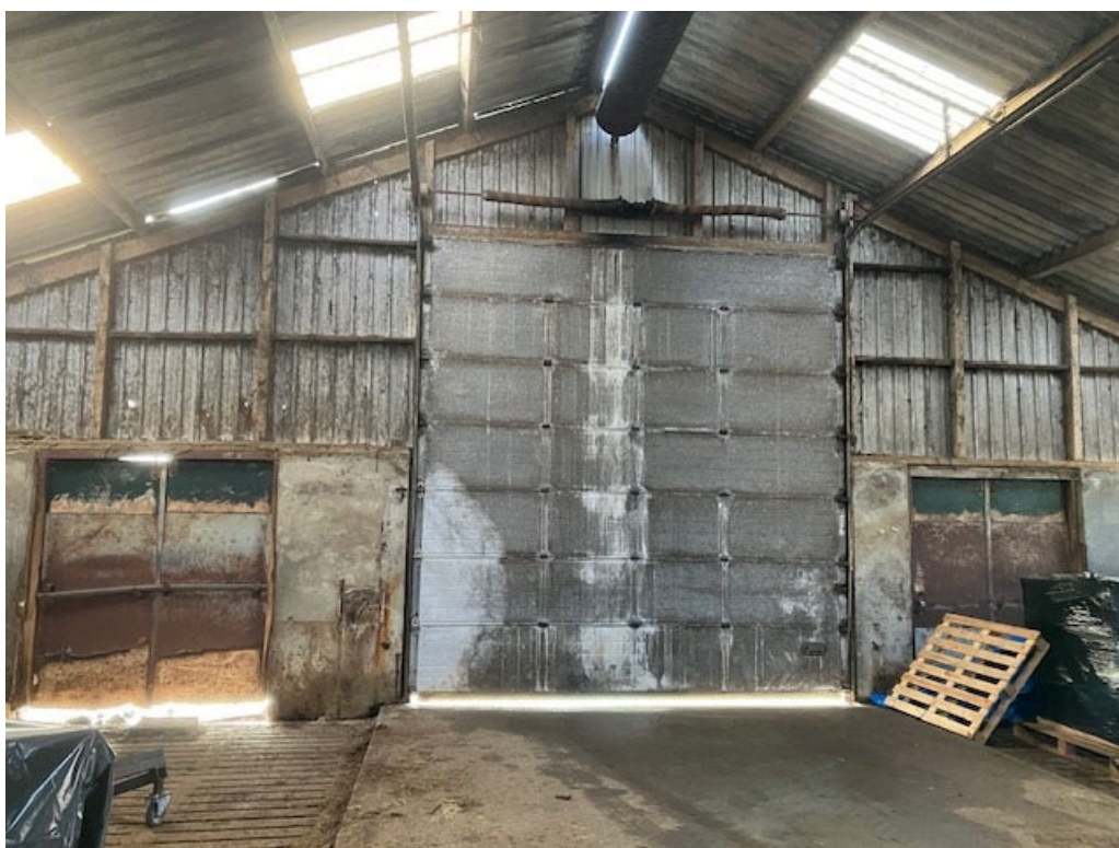
• Afbeelding 12: binnenzijde voorgevel
