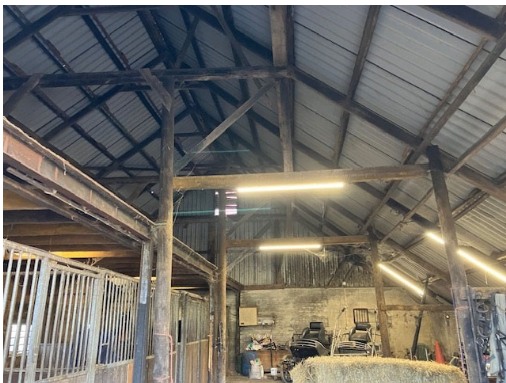
• Afbeelding 24: binnenzijde te slopen paardenstal
