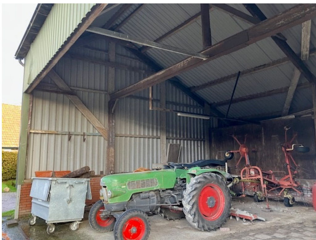
• Afbeelding 6: Te slopen veldschuur achter de bedrijfswoning
