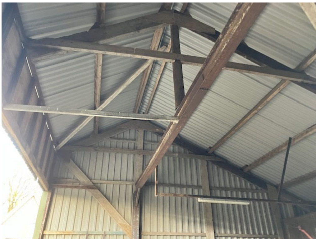
• Afbeelding 7: binnenzijde te slopen veldschuur
