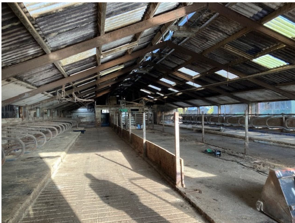
• Afbeelding 9: binnenzijde te slopen stallen, inrichting wordt gestript
