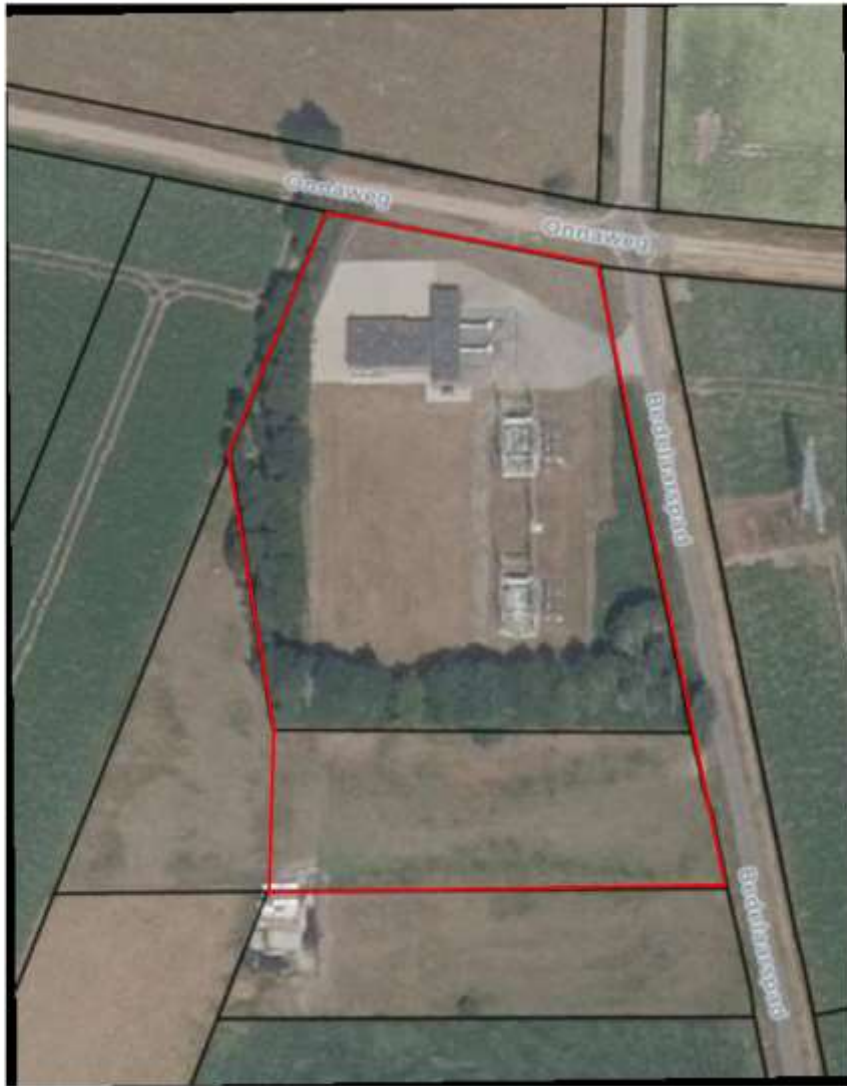
Figuur 2: Het huidige transformatorstation met het perceel (ten zuiden daarvan) waarop de voorgenomen uitbreiding zal plaatsvinden. 2
