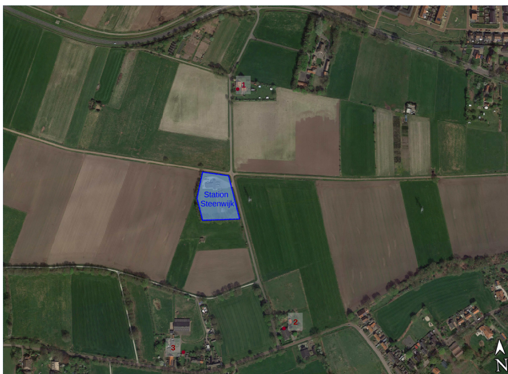
f2.1 Situering transformatorstation Steenwijk van Enexis ten opzichte van de omgeving
