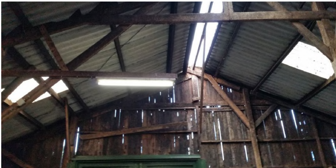
Binnenzijde schuur te slopen in fase 2
