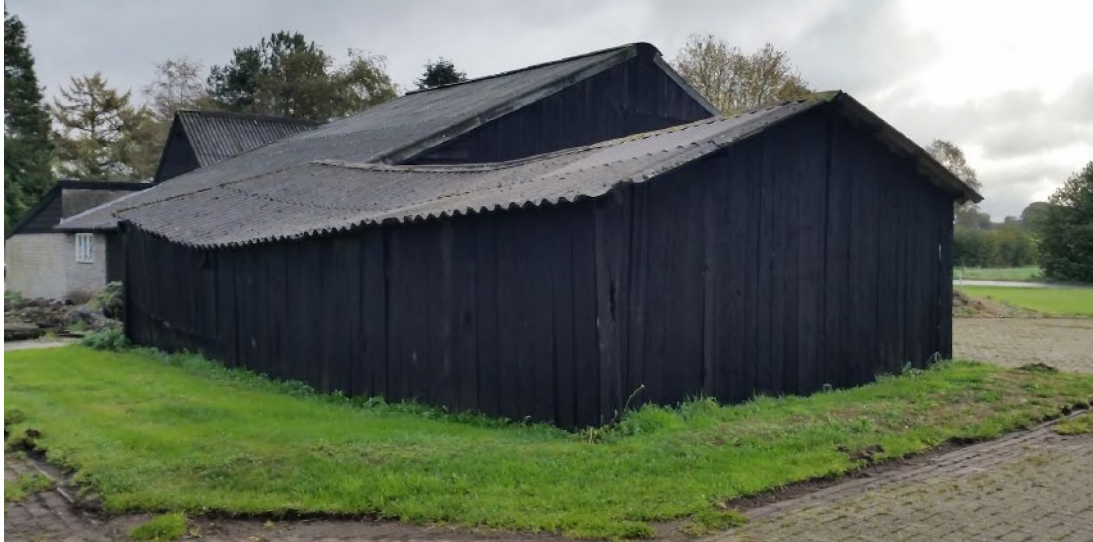
Te slopen schuur, fase 1
