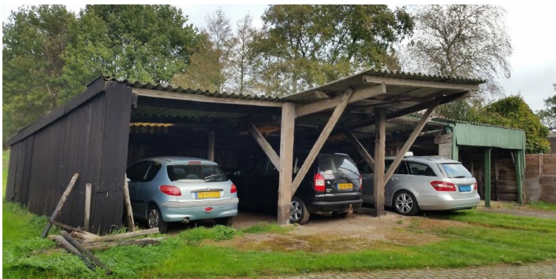
Te slopen schuur, fase 1
