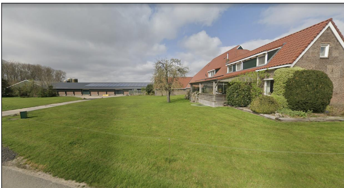
Afbeelding 2.2 Straatbeeld van de huidige situatie in het plangebied aan Rondebroek 1 westkant (Bron: Google Street view)
