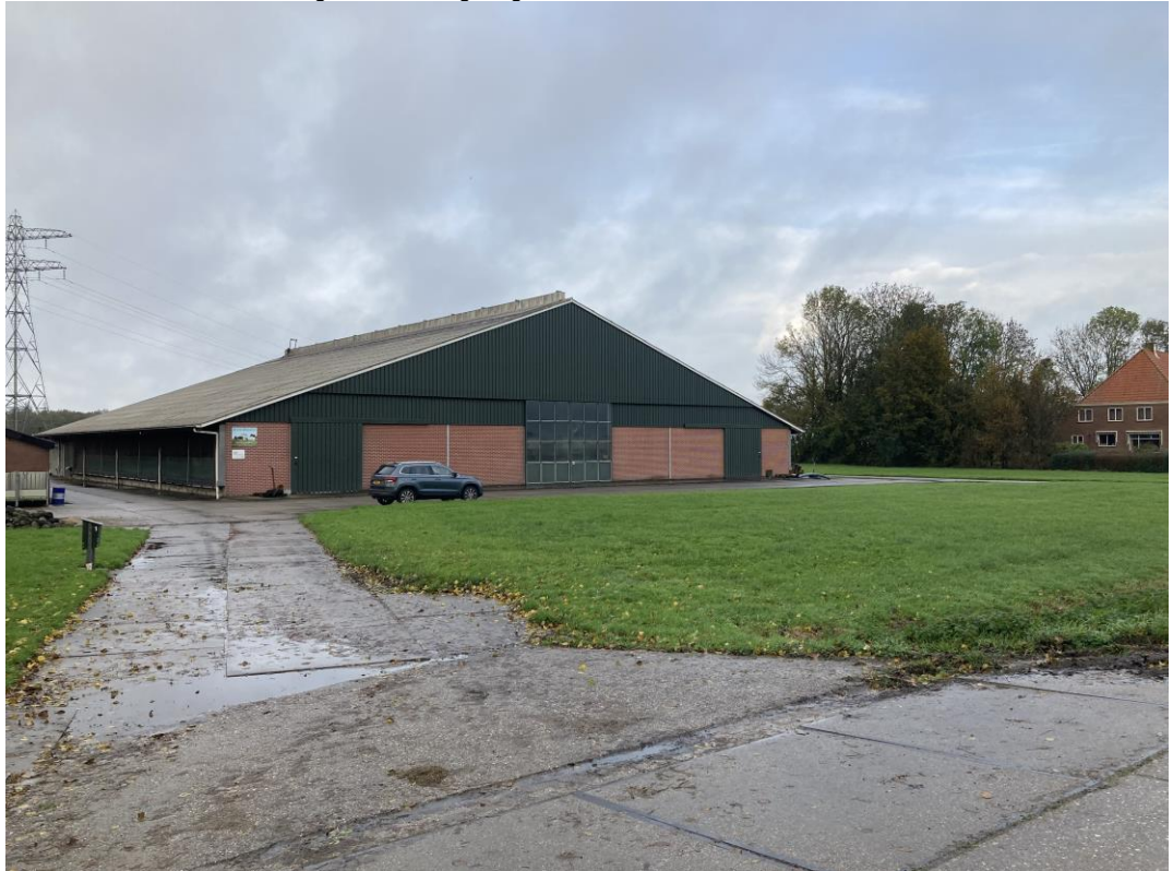
• Afbeelding 30: Te verlengen ligboxenstal
