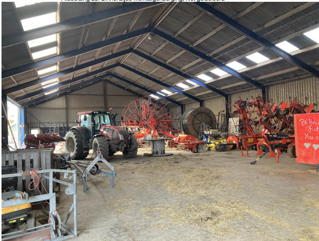
• Afbeelding 25: Binnenzijde werktuigenberging, niet geïsoleerd
