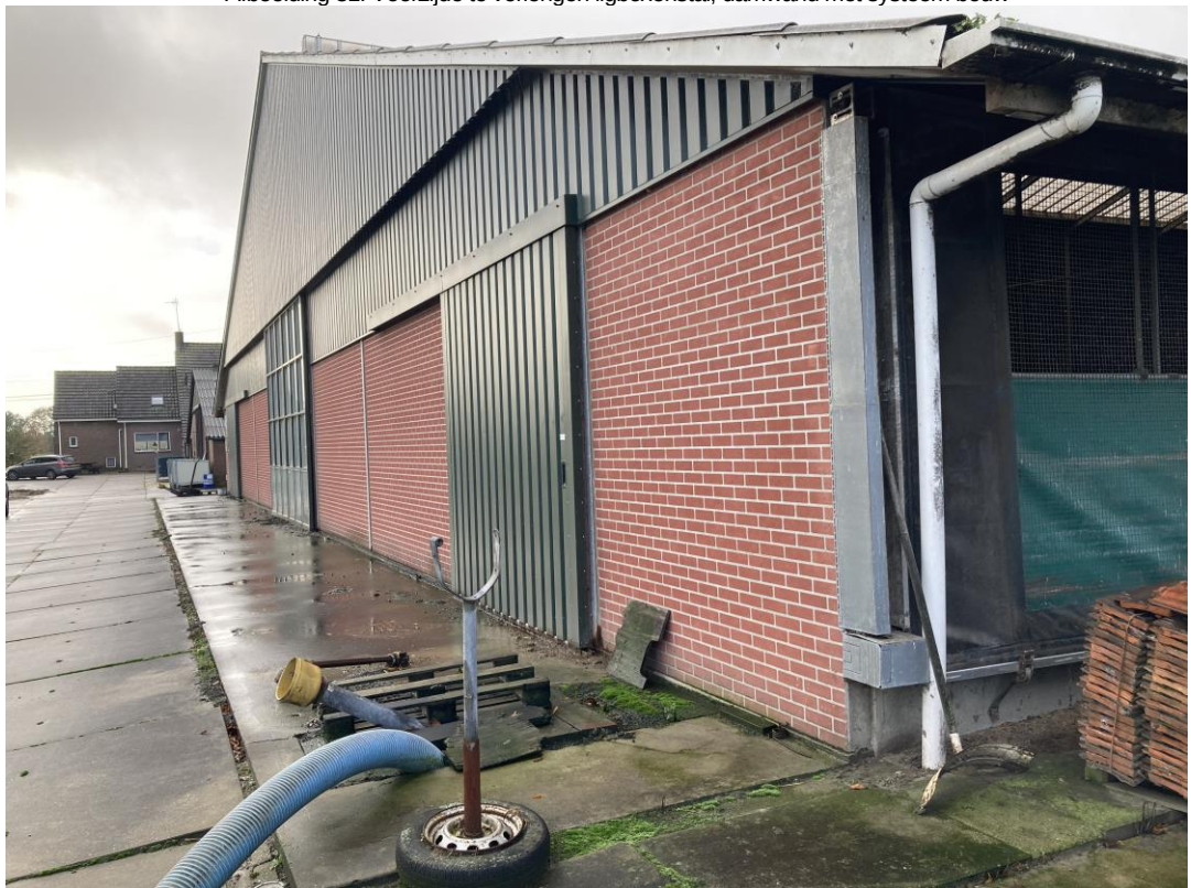
• Afbeelding 31: Voorzijde te verlengen ligboxenstal, damwand met systeem bouw
