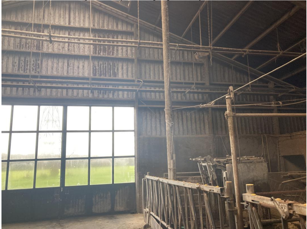
• Afbeelding 47: Binnenzijde te verlengen ligboxenstal systeemwand en damwand
