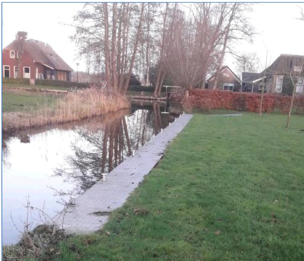
Fig. 2.3: De aanlegsteiger / bestaande kader voor de vijf sloepjes. Het betreft een foto van de huidige situatie. De aluminium traanplaat wordt vervangen door houten vlonderdelen.
