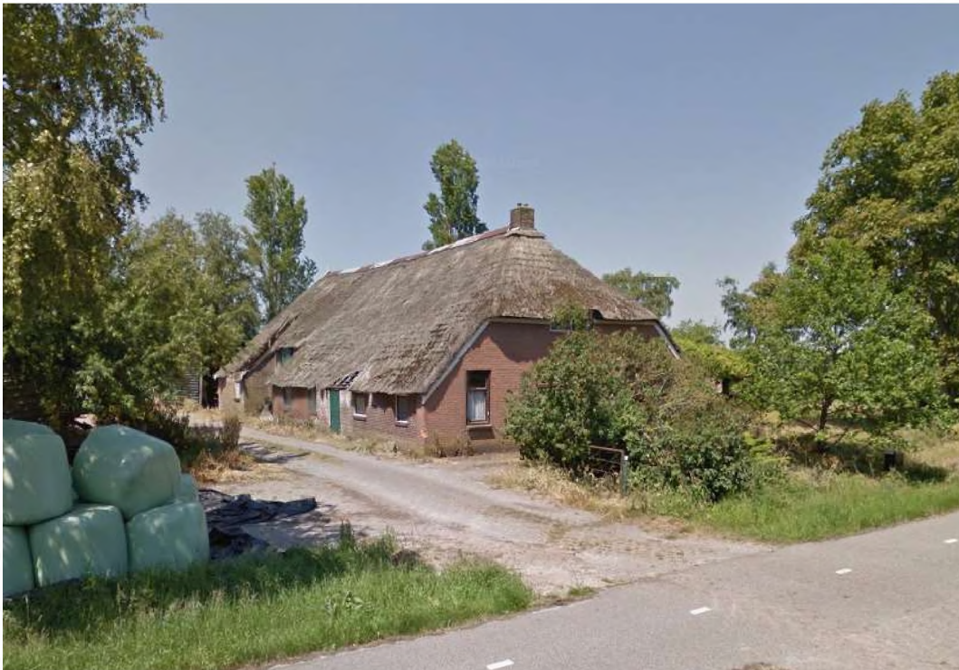
Figuur 4 Woning bevindt zich in zeer slechte staat
