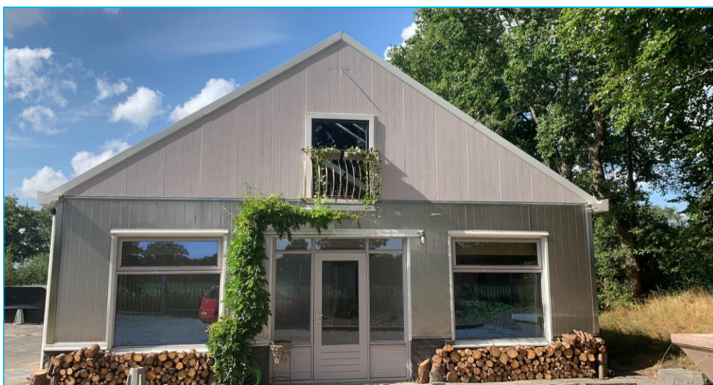
Huidige aanzicht richting tijdelijke woning (in de voormalige paardenstal). Perceel is aanzienlijk opgeknapt inmiddels.
