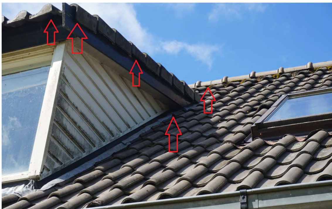
Figuur 5.4. Verschillende potentiële invliegopeningen voor vleermuizen.
