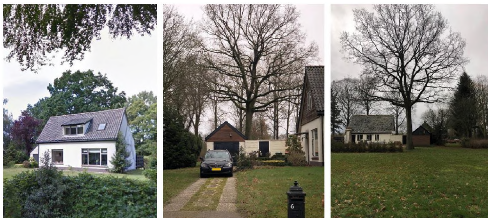
Afbeelding: Impressie plangebied met de te slopen woning en schuur
