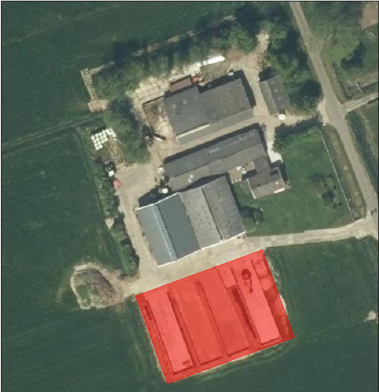
Afbeelding De sleufsilo's die gesaneerd zullen worden
