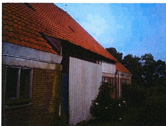
Foto 3. Niet-asbesthoudende golfplaten afdak
