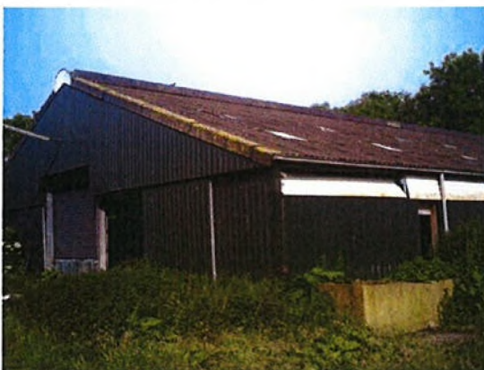
Foto 6. Niet-asbesthoudende golfplaten potstal
