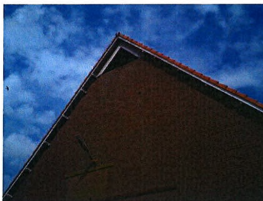
Foto 2. Asbesthoudende dakoverstek
