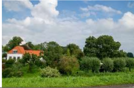
Figuur 7: D: Aanzicht vanaf de Blokzijlerdijk
