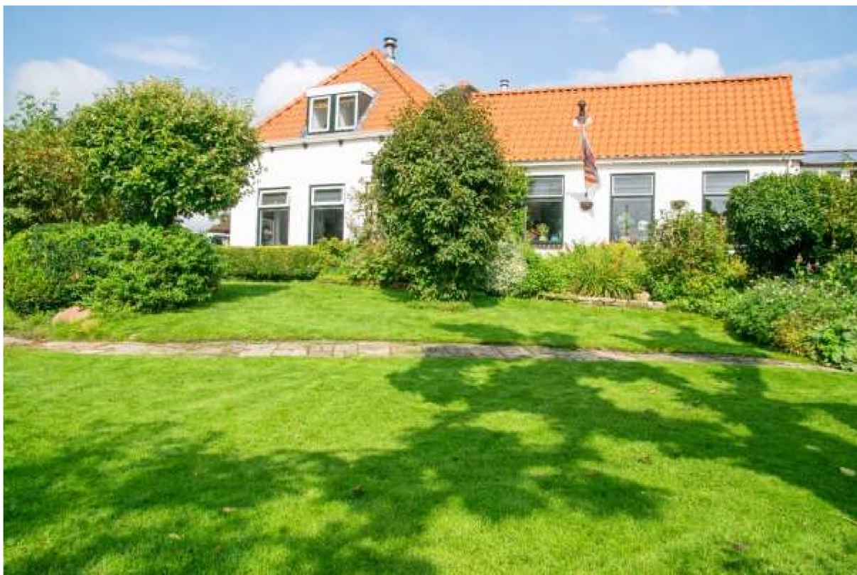
Figuur 3. Aanzicht op de bestaande woning
