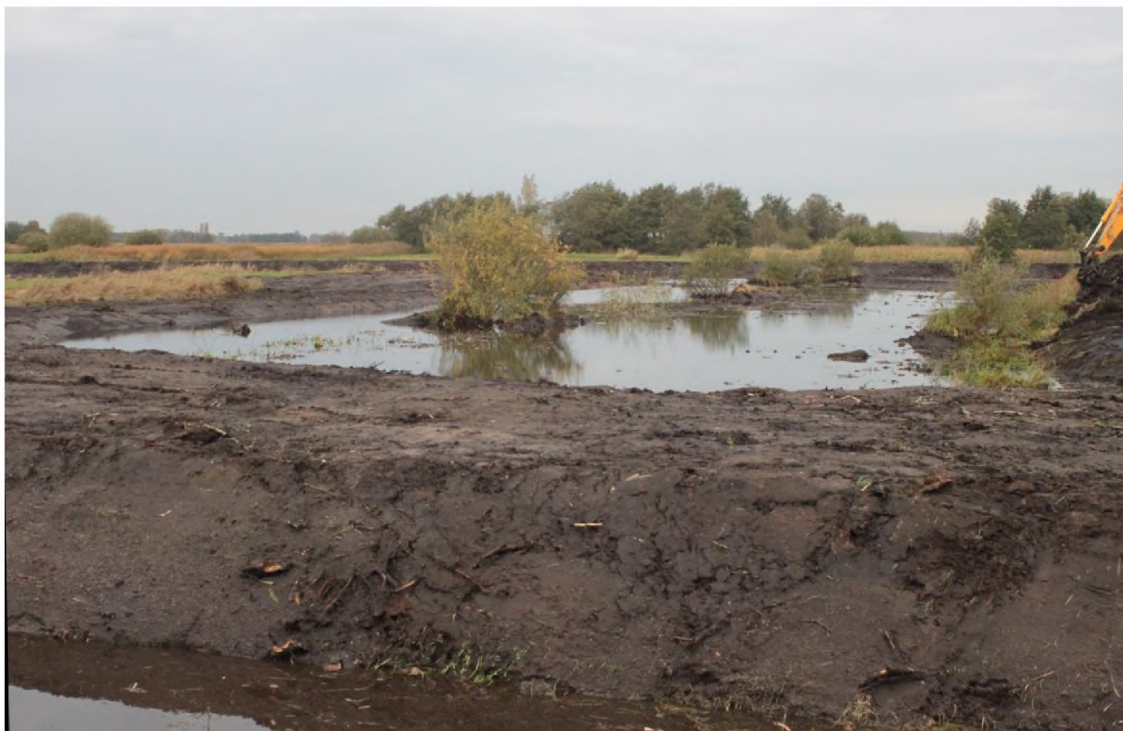
Foto 2-2 - Inrichtingswerkzaamheden Brouwers Zuid, oktober 2012 (foto A&W).
