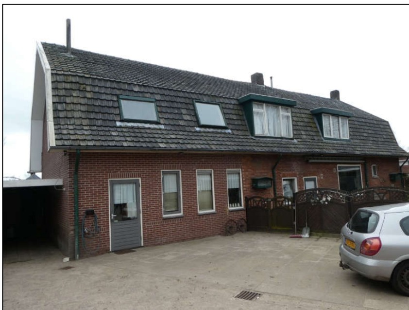
Figuur 5: Foto van de achterzijde van de woning in de huidige situatie
