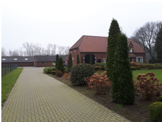
Woonhuis (A), met groen naast oprit
