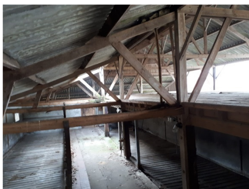
Kapschuur D open gedeelte inclusief (hooi)zolder en veeroosters
