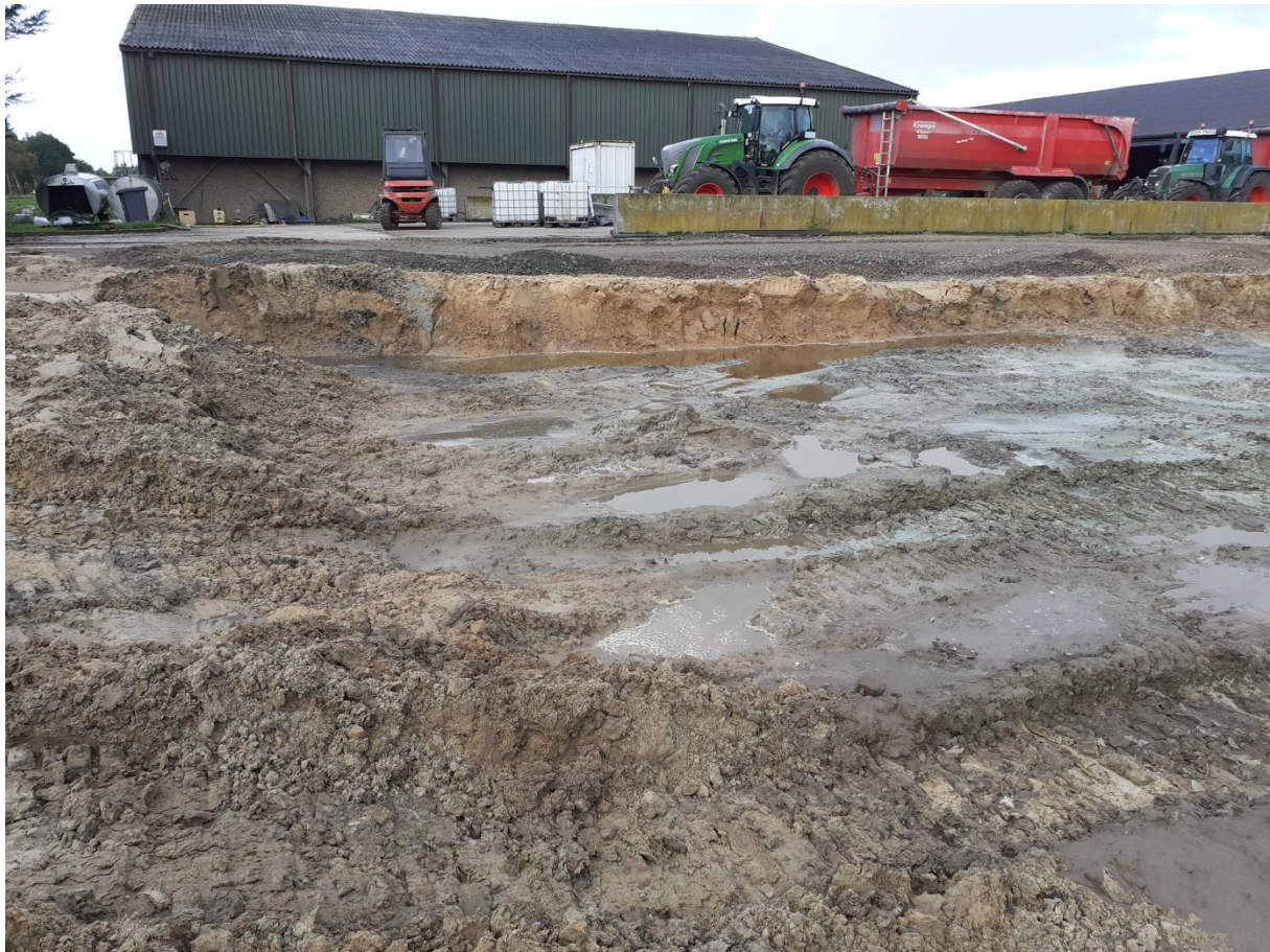
Afb. 9 Situatie na de sloop van de varkensstal
