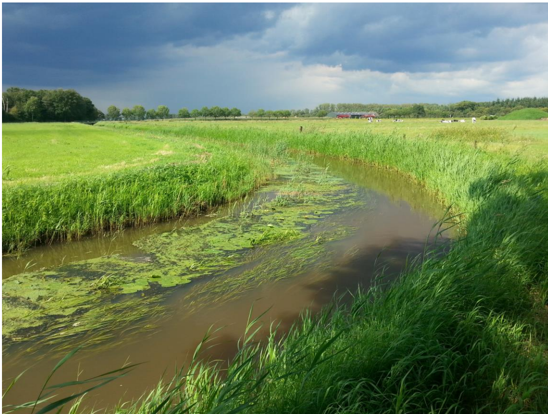
Foto 2. Impressie verbrede en gekanaliseerde Bulder Aa ter hoogte van de onderdoorgang met de weg D'Aasdonken.
