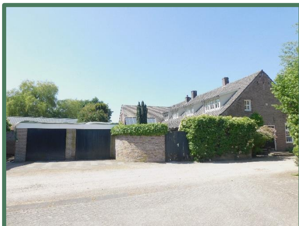
Achterzijde woning met garage
