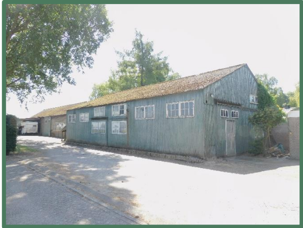
Overzicht voorste schuur
