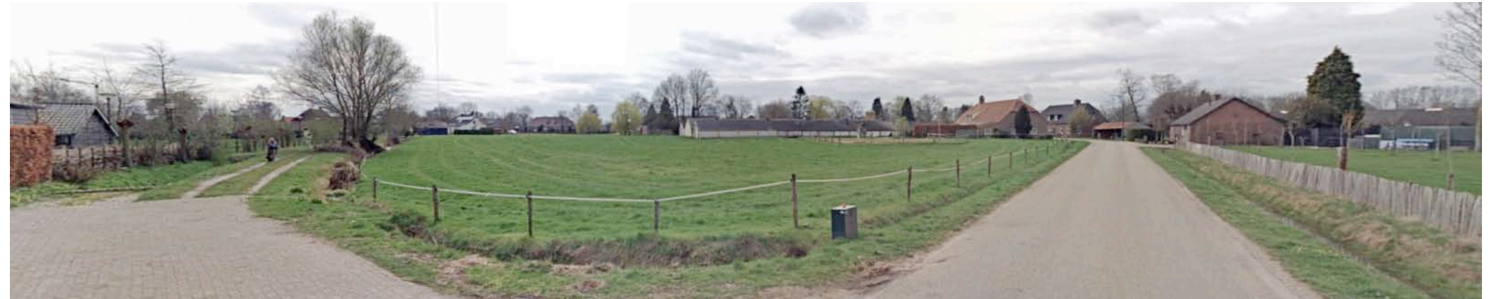
1+2) uit het noordoosten; de stallen reiken ver in het open akkerland, zijn prominent aanwezig...
