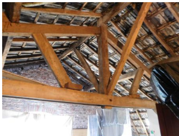
Figuur 2 - Binnenzijde van het dak van de aanbouw onder zadeldak achter het voormalige bedrijfsdeel. Het dak is onbeschoten.
