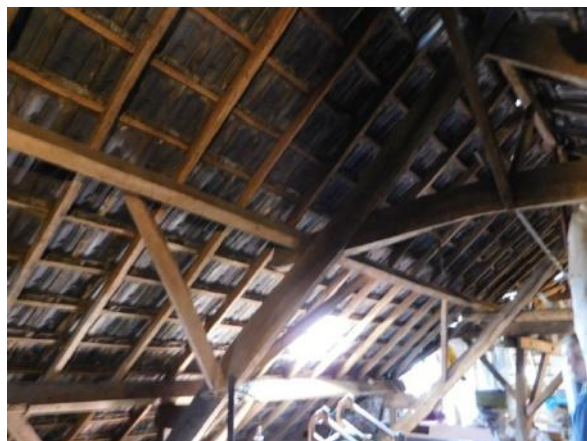
Figuur 2 - Binnenzijde van het dak van de aanbouw onder zadeldak achter het voormalige bedrijfsdeel. Het dak is onbeschoten.
