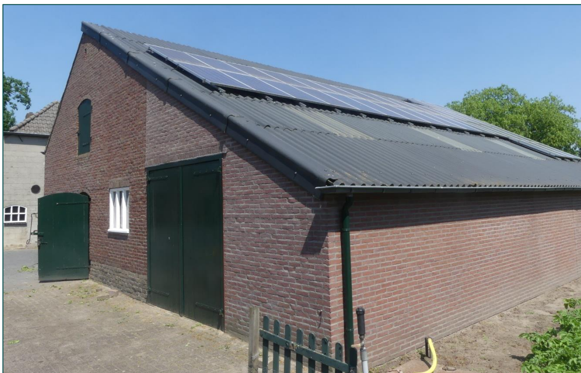
Figuur 2 Een van de schuren op de planlocatie wordt in de beoogde ingreep verbouwd tot een woning.
