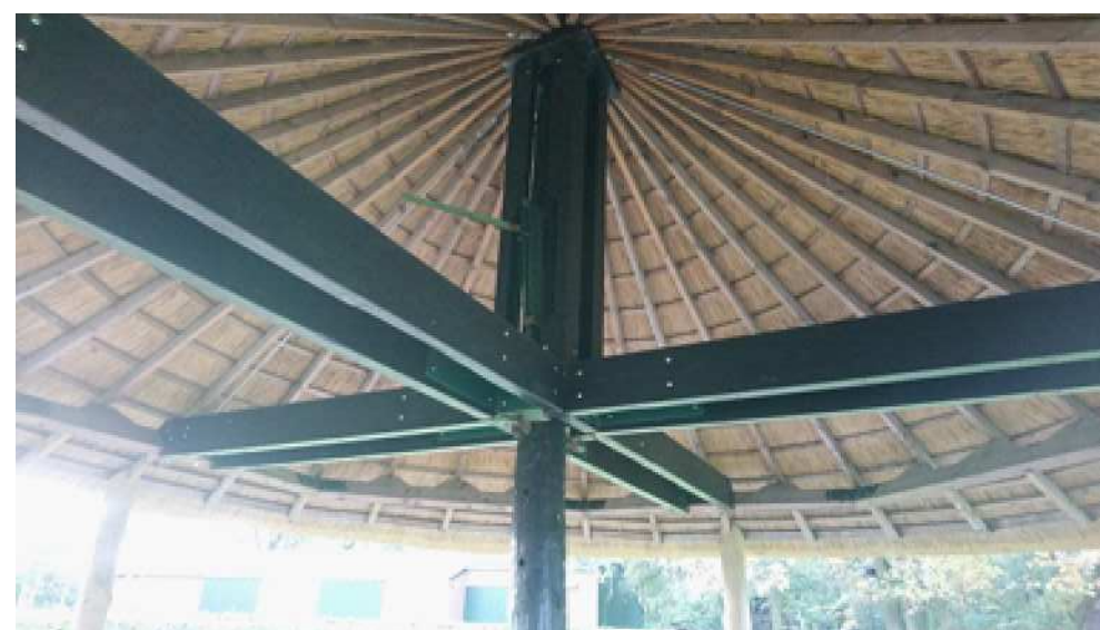
'detaillering onderzijde hooimijt'
