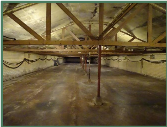
Binnenzijde middelste pluimveestal
