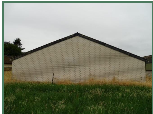
Middelste pluimveestal oostzijde
