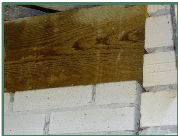
Muurplaat direct op de spouw middelste stal
