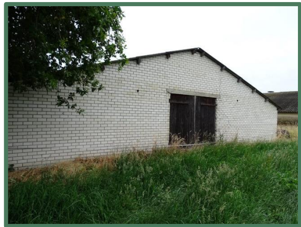
Zuidelijke pluimveestal oostzijde
