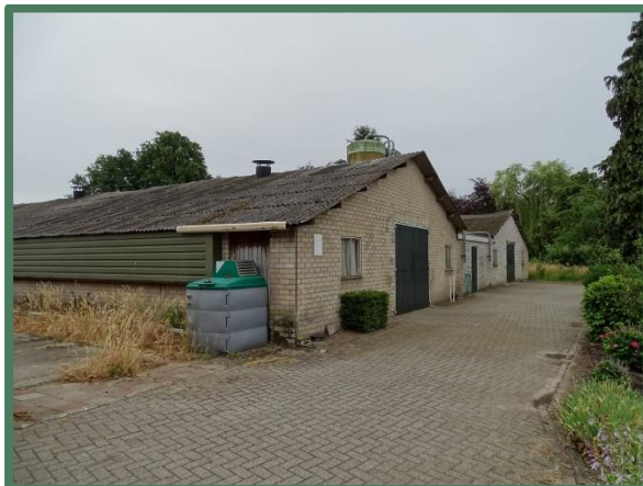
Middelste pluimveestal westzijde
