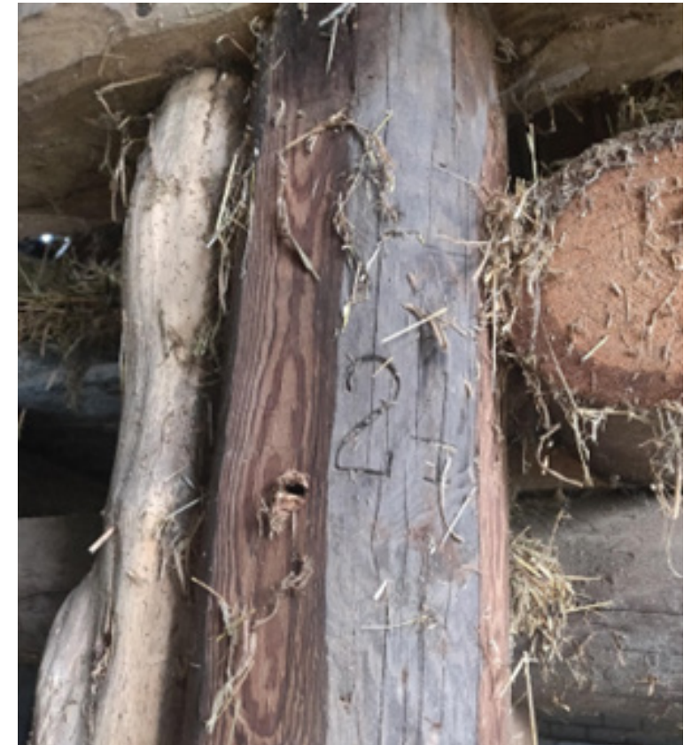
hergebruikte elektriciteits-/telefoonpaal. Worden in het ontwerp weer hergebruikt.
