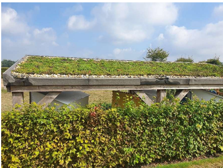
Bestaande overkappingen met mos-sedumdak ter bescherming van de kinderbedjes
