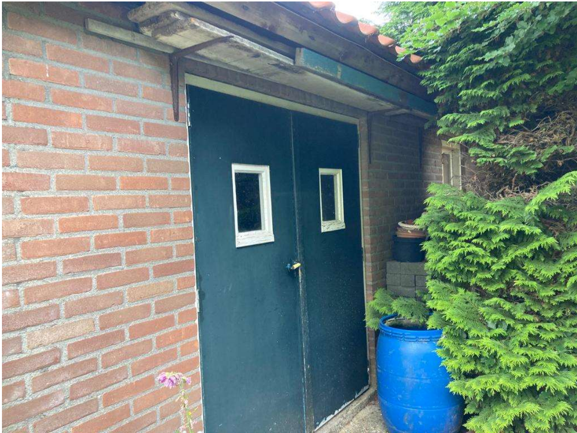
• Afbeelding 7: Detail rechterzijgevel
