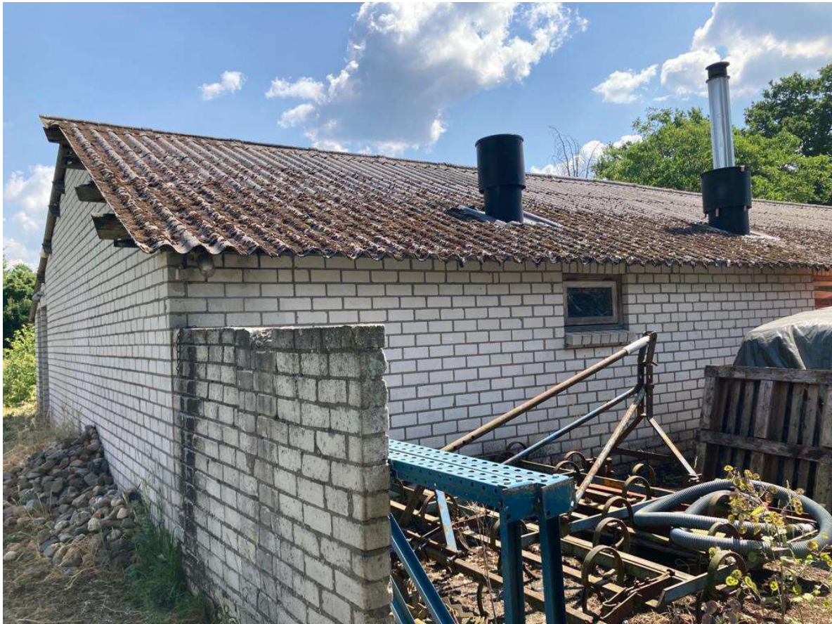
• Afbeelding 10: Achtergevel varkensstal
