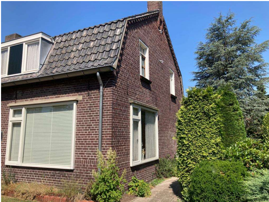
• Afbeelding 4: Voorgevel bedrijfswoning
