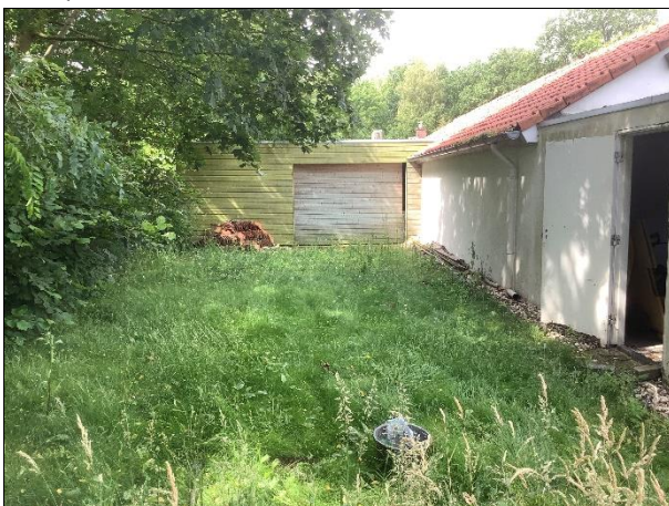
Foto 5 De zuidgevel van de schuur op het woonperceel.
