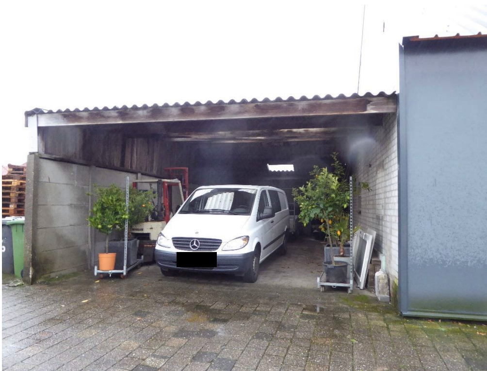
Figuur 6. Een open kapschuur kon geheel onderzocht worden. Hier zijn geen aanwijzingen gevonden voor aanwezigheid van beschermde soorten.
