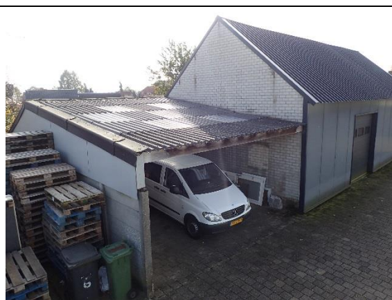
Foto 8. Aanbouw loods, asbestvrije golfplaten
