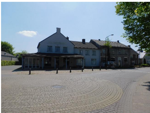
Voorgevel te slopen bebouwing
