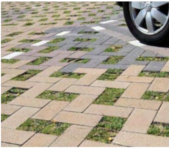
Groenparkeren NCB-klinker (MBI), kleur antraciet (links) of groen parkeren met betonklinkers keiformaat (idem aan rijbaan) in elleboog verband met tussenruimte voor groen (rechts)
