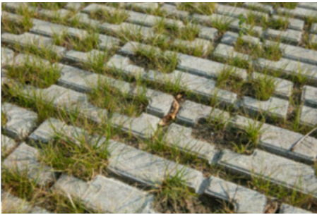
Groenparkeren NCB-klinker (MBI), kleur antraciet (links) of groen parkeren met betonklinkers keiformaat (idem aan rijbaan) in elleboog verband met tussenruimte voor groen (rechts)
