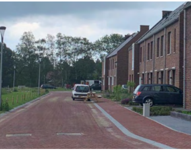
weg en trottoir op zelfde niveau
