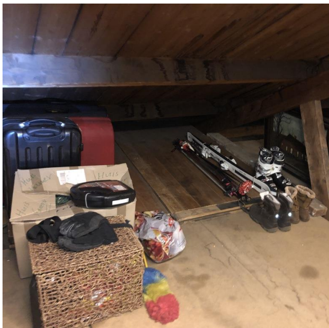
Zolder dakbeschot bovenwoning
