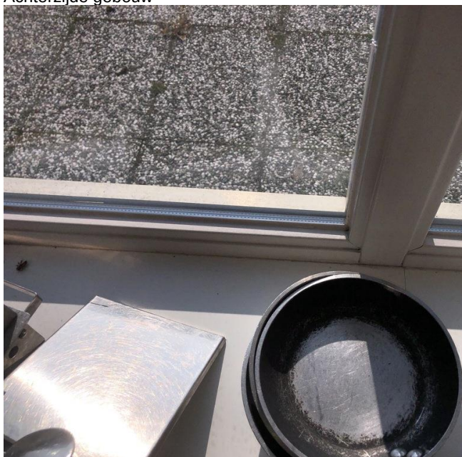
Kozijnen en vensterbanken vernieuwd
