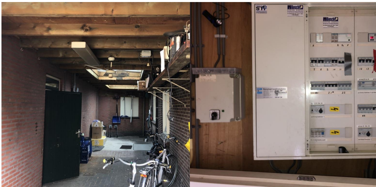
Afdak en koelcel
