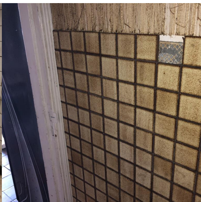
Keuken, tegelwerk in cementgebonden tegellijm
