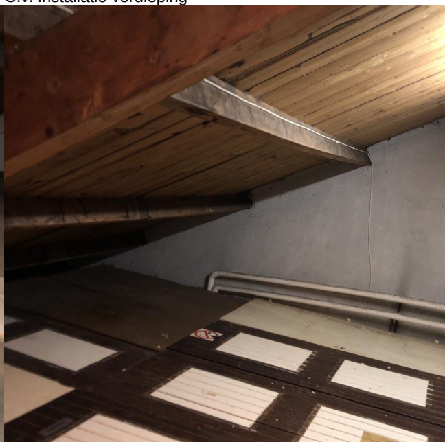
Zolder dakbeschot bovenwoning
