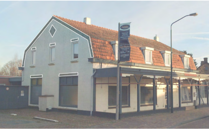
Schutje accenten in metselwerk. Gebakken dakpannen.
