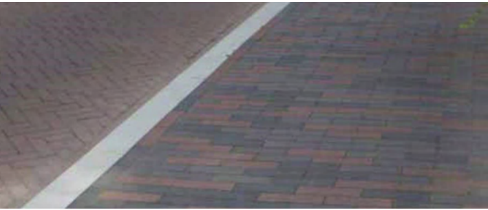
Voetpaden uitgevoerd in GeoRetron Prestige, mix van roodbruine-bruine-zwartbruine tinten, dikformaat in halfsteensverband en de rijlopers in gebakken klinkers, keiformaat, roodbruin-bruin van kleur in keperverband.
