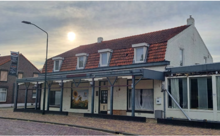
Schutje accenten in metselwerk. Gebakken dakpannen.
