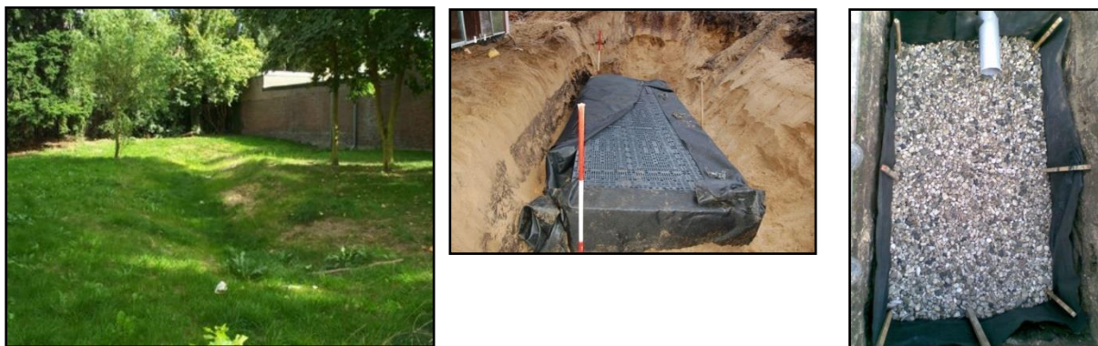
Figuur 29: Voorbeelden van infiltratievoorzieningen
