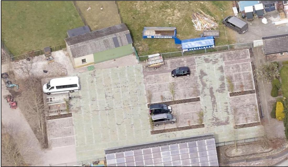
Figuur 15: Nieuw aangelegde parkeerplaats
