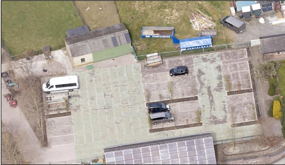
Figuur 15: Nieuw aangelegde parkeerplaats
