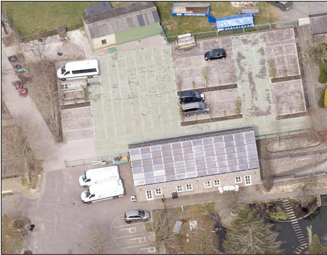
Figuur 12: Luchtfoto met het parkeerterrein binnen het plangebied in de huidige situatie
