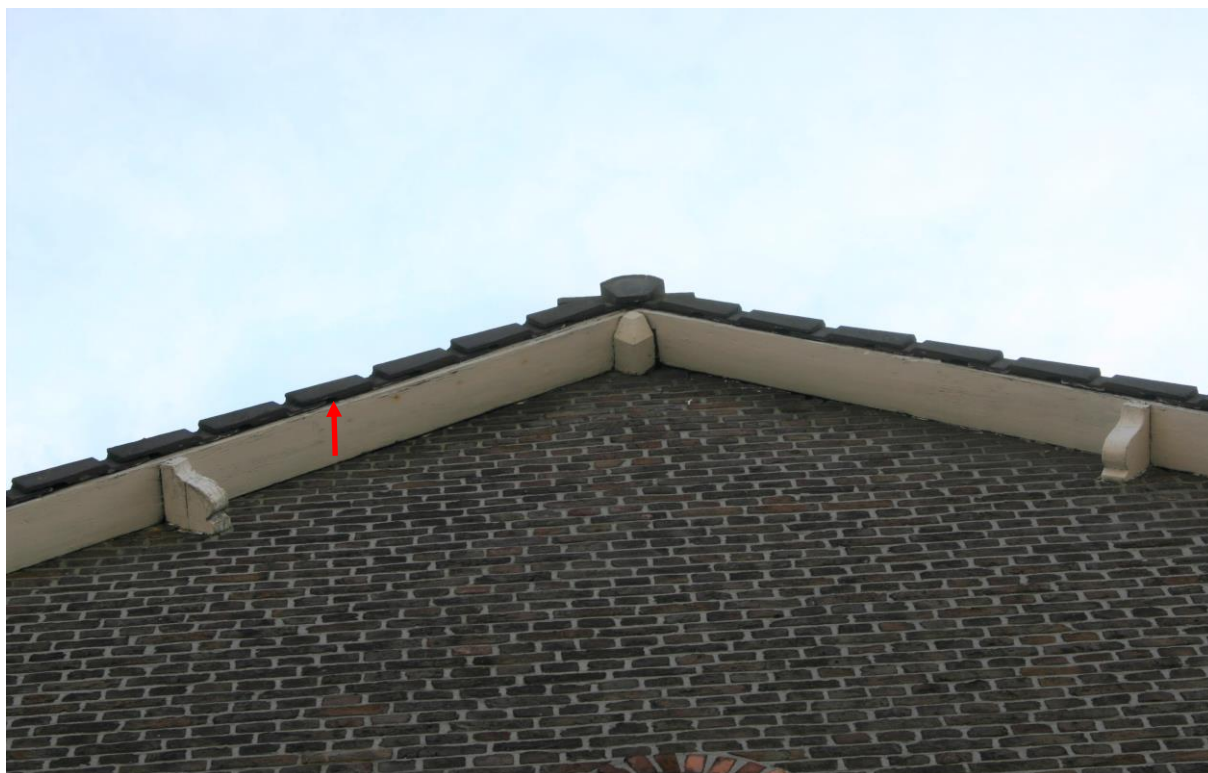
Figuur 4.2.2. Op de kopse kanten van de hoge bouw is genoeg ruimte onder de gevelpannen (rode pijl) voor gierzwaluwen.
