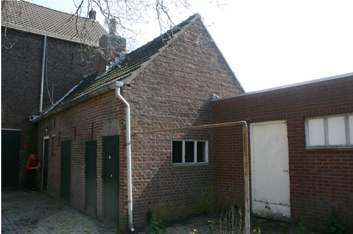
Figuur 4.2.1. De aanbouw met het zadeldak aan de westzijde (l) heeft afgestreken gevelpannen, geen dakbeschot en geen spouw; hier is geen ruimte voor vleermuisverblijven. De garage (r) heeft geen open stootvoegen en een nauw aansluitende daktrim.
