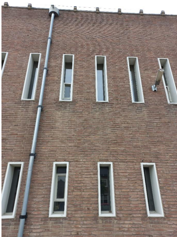
Hoofdbouw met open stootvoegen boven de ramen.
