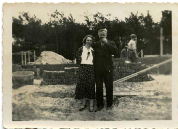
Figuur 5 - Bouwheer Jan Koenraadt met zijn verloofde Koosje van Agtmaal tijdens de bouw van hun villa, Hugten, 1935.
