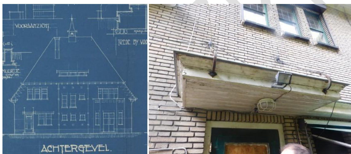
Figuur 9 - Links de achtergevel volgens de bouwtekening van 1935 9 ; rechts een detail van het fraai gedetailleerde afdakje boven de keukendeur.
