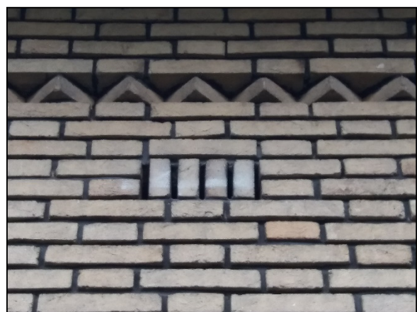
Figuur 11. Openingen die toegang verlenen tot de spouwmuren voor vleermuizen.
