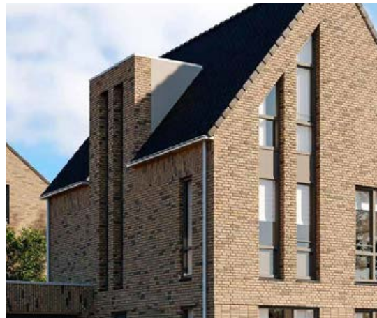
Dakkapel in gevelvlak op de kopgevel.
