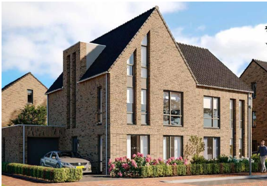
Raampartijen over meerdere lagen en doorlopend in dakvlak.
