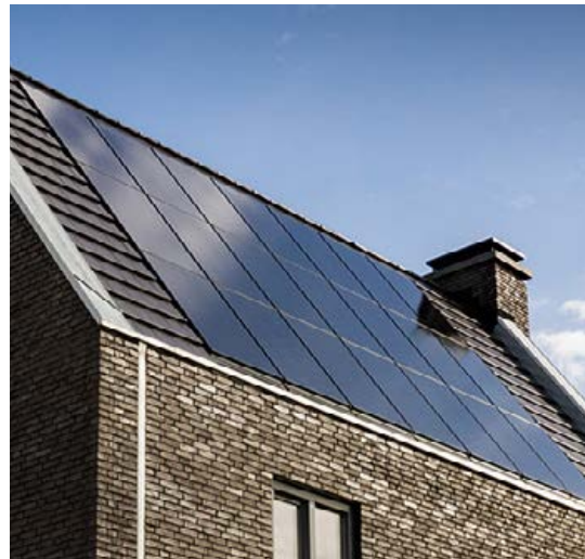
Een eenduidig blok met zonnepanelen
