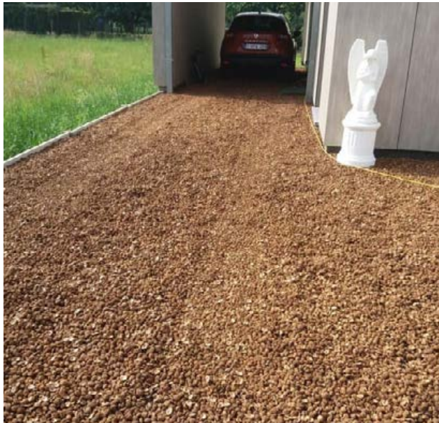
Verharding van pitten, duurzaam alternatief voor grind.
