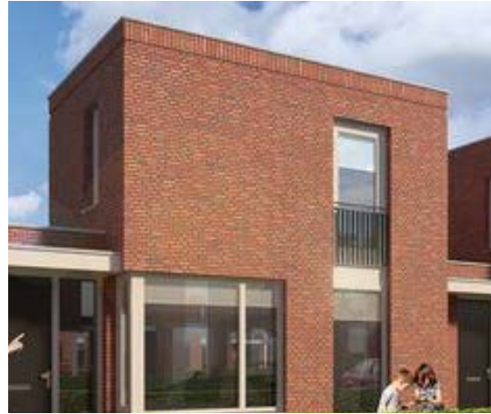
Baksteen detail dakrand, overhoeks raam.
