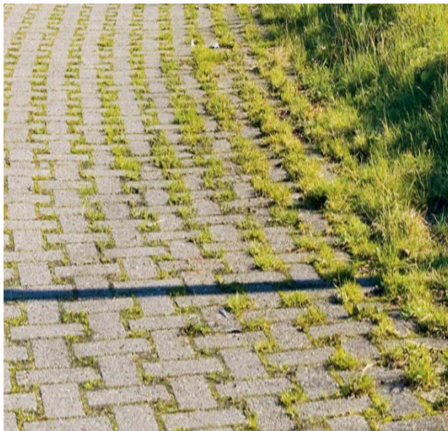
Alternatieve bestratingspatronen met hoge waterdoorlatendheid.
